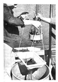
Abb. 13. Bodengreifer, nach Auerbach, und Auswaschen gefasster Schlammproben im Schlammsiebnetz zur Erkundung der tierischen Besiedlung am Gewässergrunde.
