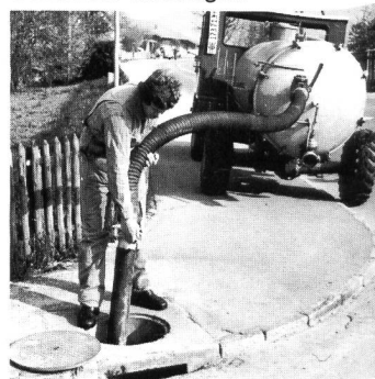
Kanalisationen reinigen
