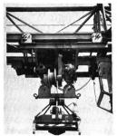
Federkabeltrommel als Stromzuführung zu einem Motor-Hydraulik-Baumstammgreifer, Kabelabzug vertikal
