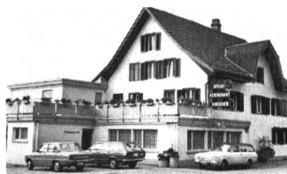
Fassadensanierung mit vorgehängten Fassadenschiefern «Eternit»
