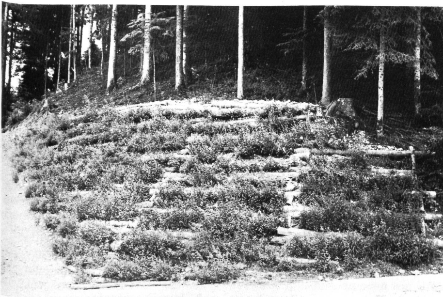
(zu 3.2). An der Stelle von herkömmlichen Betonstützmauern im Strassenbau lassen sich die besser in die Landschaft einfügenden ingenieur-biologischen Bauweisen verwenden, zum Beispiel ein Hangroost an der Umfahrungsstrasse in Signau/Emmental.
