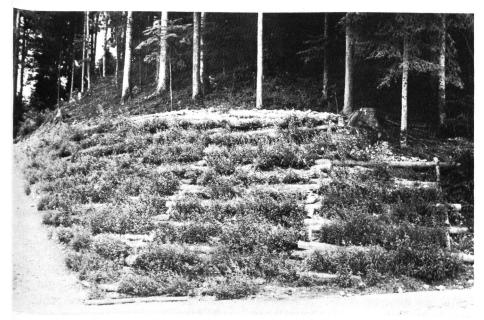
(zu 3.2). An der Stelle von herkömmlichen Betonstützmauern im Strassenbau lassen sich die besser in die Landschaft einfügenden ingenieur-biologischen Bauweisen verwenden, zum Beispiel ein Hangrost an der Umfahrungsstrasse in Signau/Emmental.
