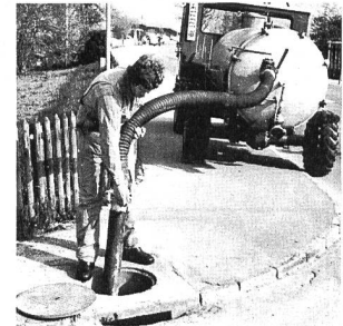
Kanalisationen reinigen
