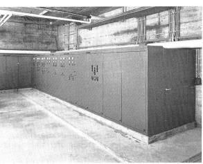
Niederspannungs-Hauptverteilung mit Pumpensteuerung ARA Augarten Rheinfelden
