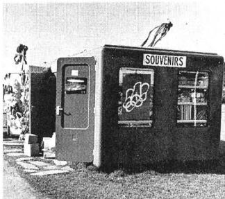
hochwertigem glasfaserverstärktem Kunststoff (GFK) hergestellt sind. Die zweckmässige und formschöne Konzeption der Elemente ermöglicht eine bemerkenswerte Kombinationsfreiheit bezüglich Grösse und individueller Gestaltung der Kabinen. Zudem gestattet sie kürzeste Zusammenbauzeiten und minimalen Unterhalt.
