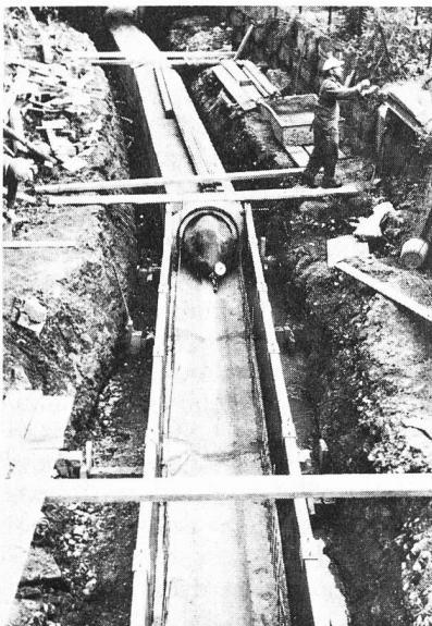
Besondere Beachtung verdienen die danach erstellten Ortsbetonkanäle mit Sonderprofil mit ihren Vorteilen bei der Arbeitsausführung und in der Wasserführung, insbesondere bei hochgelegenem Vorfluter und bei geringer Überdeckung.
