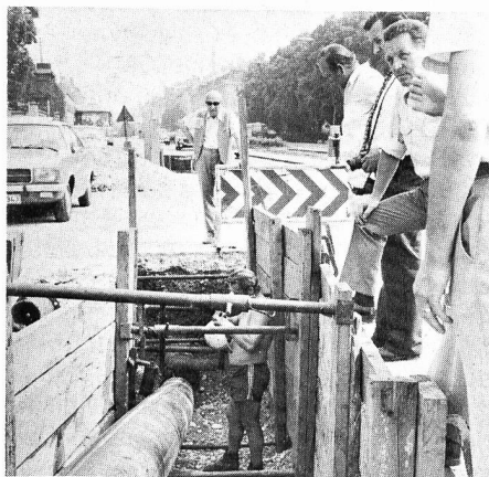
Einreihen eines PE-h-Rohrstrangs
