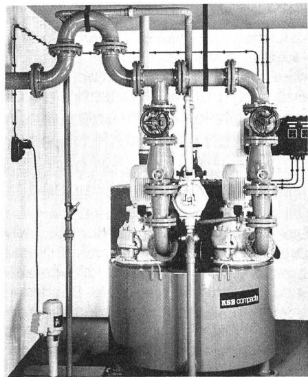
Der Trend zu stecker- und anschlussfertigen Kompaktanlagen ist besonders bei Kleinhebeanlagen sehr stark, da sie eine Installation mit geringstem Aufwand ermöglichen.
