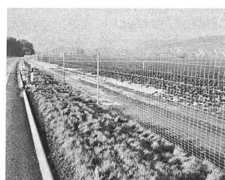
Die Anwendung der neuen «Zaunfix-Feder-Verspannung» ermöglicht eine Verdoppelung der Pfostendistanzen. Die Hälfte der Zaunpfostenanzahl samt Fundamenten kann eingespart werden. Mit dem Patentsystem sind somit Pfostenabstände bis zu 12 m möglich.
