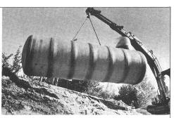
Der korrosionssichere S+O-Heizöltank aus glasfaserverstärktem Polyester
