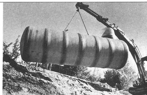
Der korrosionssichere S + O-Heizöltank aus glasfaserverstärktem Polyester
