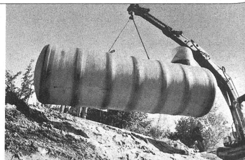
Der korrosionssichere S + O-Heizöltank aus glasfaserverstärktem Polyester
