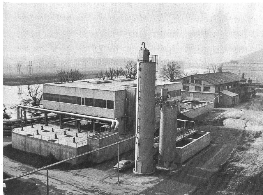
△ Cellulose Attisholz AG Mechanisch-chemische Abwasserreinigungsanlage MEKA
