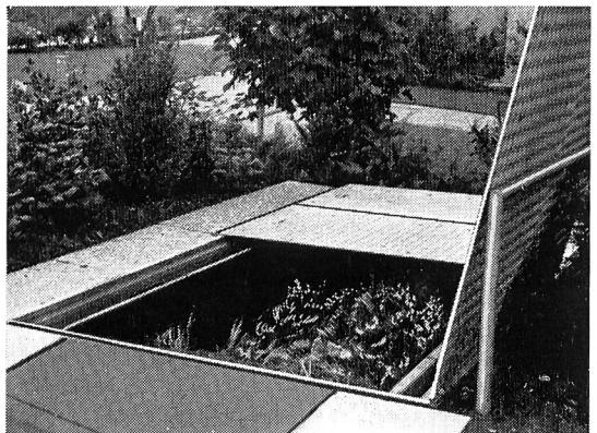
Die vorfabrizierten SME-Beton-Muldengruben eignen sich für Wechsel lade-Mulden und Abfallgruben. Sie bringen Ordnung in den Betrieb und brauchen keinen Unterhalt. Sind rasch eingebaut (1 – 2 Tage).
