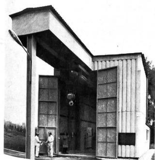
Gesamtansicht des oberirdischen Teils der Anlage Geiselbullach bei München mit Steuer- und Strahlenüberwachungsgeräten sowie Klärschlammbehälter
