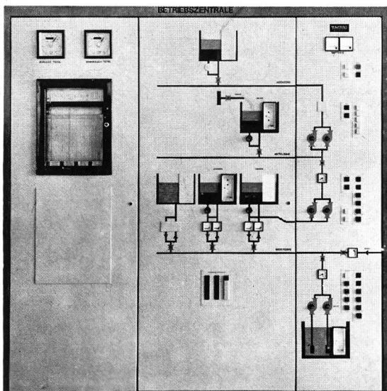
Fernmess- und Fernsteuerungsanlage zur Wasserversorgung für 10000 Einwohner, mit 5 Reservoirs, 3 Pumpwerk- und 3 Quellensteuerungen. Zuflüsse, Abflüsse und Verbrauch elektronisch gesteuert und gemessen
