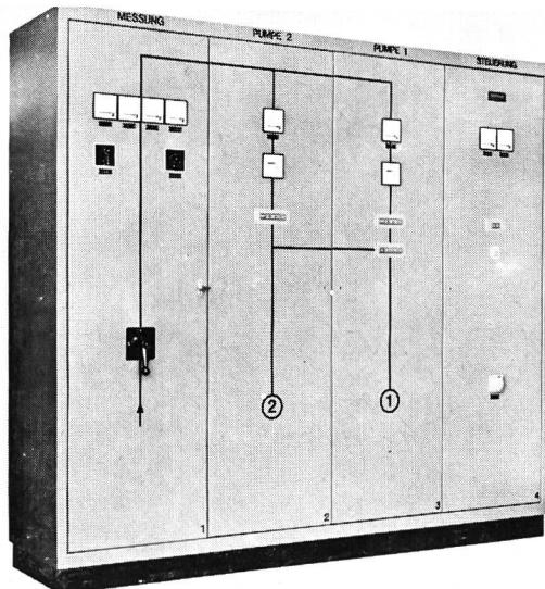
Pumpwerk-Steuerungsanlage für zwei Grundwasserpumpen
