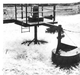
Abb. 1. Cyclo-Motorgetriebe als Belüfterkompaktantriebseinheit in einer Kläranlage
