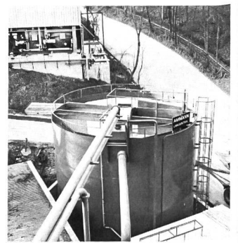
Ammann-Schlammwasserkläranlage KA 75 installiert in Kieswerkbetrieb
