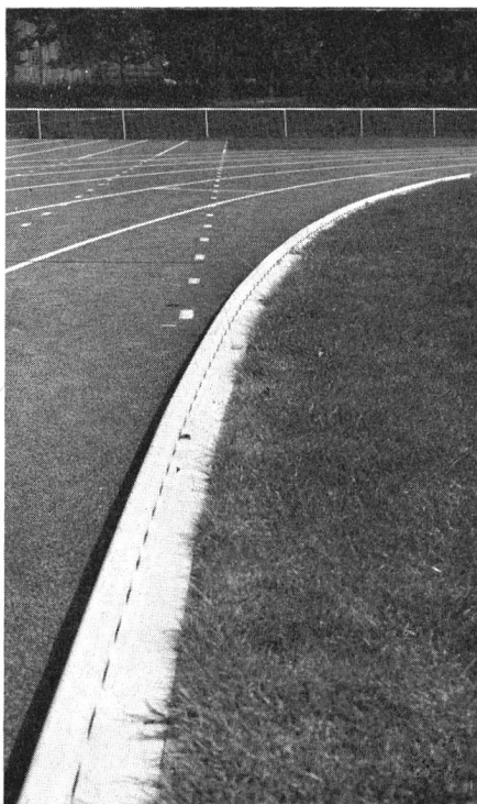
Abb. 4. Leichtathletikstadion Wankdorf Bern. November 1973 — Einbau der Entwässerungsrinnen
