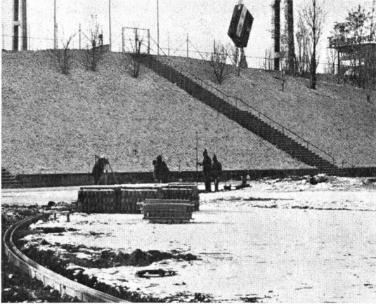
Abb. 4. Leichtathletikstadion Wankdorf Bern. November 1973 — Einbau der Entwässerungsrinnen
