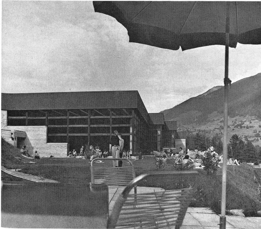
▲ Das Hallenbad Fiesch. Vorfabrizierte Decken-, Träger- und Fassadenelemente auf Unterbau und Ortsbeton bilden die Struktur. Das Fassadenstirnband ist mit schwarzen Schiefern «Eternit» verkleidet
