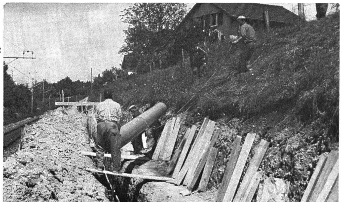
KALIDUR-Kanalisationsrohre, verlegt im Bahneinschnitt
