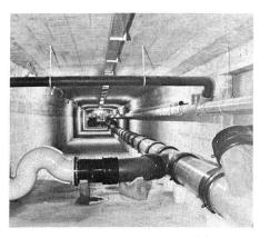
Für den Drucksektor bis 16 kp/cm² Betriebsdruck bietet die Straub Kupplungen AG Rohrverbindungen unter der Typenbezeichnung «Tubogrip 16», ebenfalls für zylindrische Rohre ohne deren Endenbearbeitung (nur Kanten brechen), an. Die Tubogrip-16-Verbindungselemente werden mit der gleichen Montagetechnik und ebenfalls sehr kurzen Verbindungszeit auf Druckrohre montiert. Dieser Rohrverbin-
