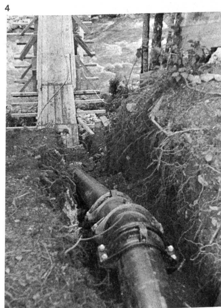
Abb. 3. Grabarbeiten im steilen Gelände
