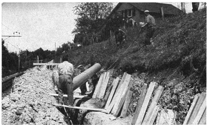
KALIDUR-Kanalisationsrohre, verlegt im Bahneinschnitt
