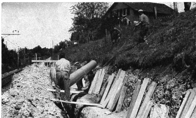
KALIDUR-Kanalisationsrohre, verlegt im Bahneinschnitt
