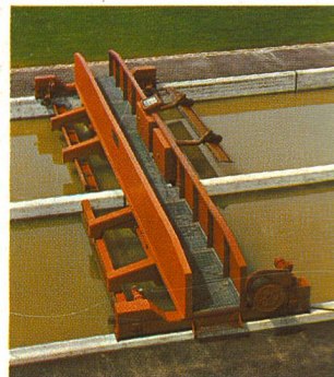
Hydraulische Räumer ARA Aadorf
