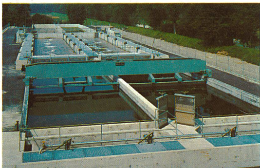
Hydraulische Räumer ARA Pfungen
