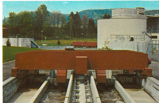
Hydraulische Räumer ARA Aadorf
