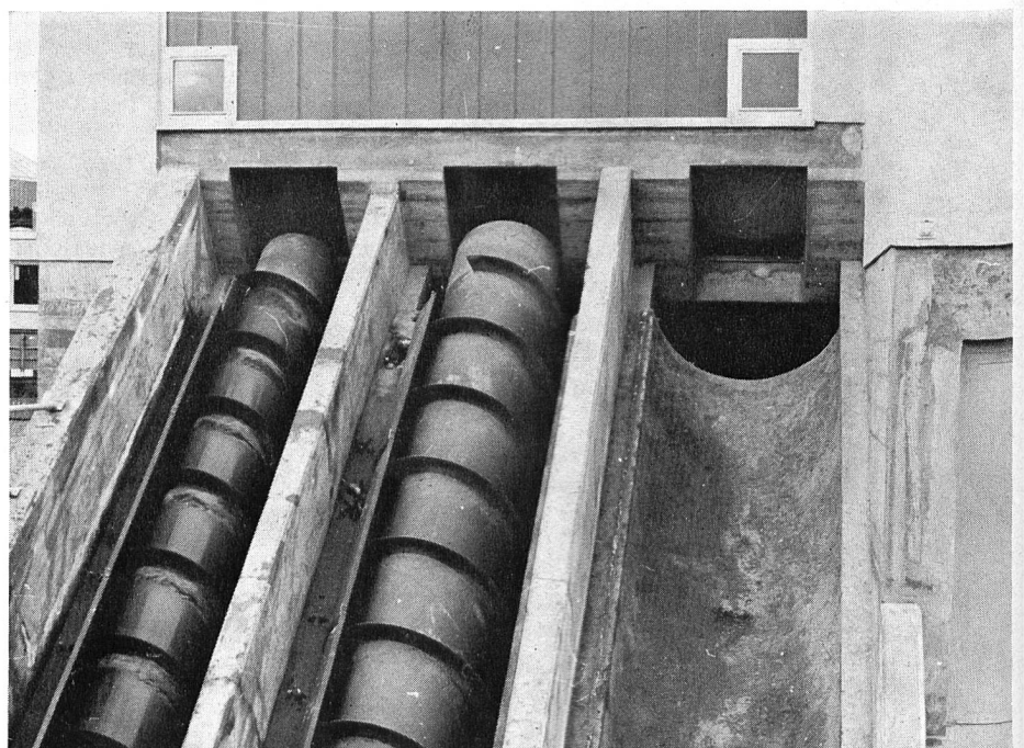
Abb. 1. Blick auf den Sandfang; im Vordergrund die Mammutpumpen für den Sandfang, im Hintergrund der Sandfangräumerwagen
