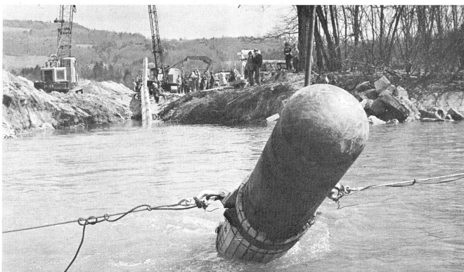
Abb. 1. Verlegearbeiten an der Swissgas-Leitung West bei Dürrenäsch Abb. 2. Verlegung des Reuss-Dükers der Swissgas-Leitung West bei Fischbach-Götslikon
