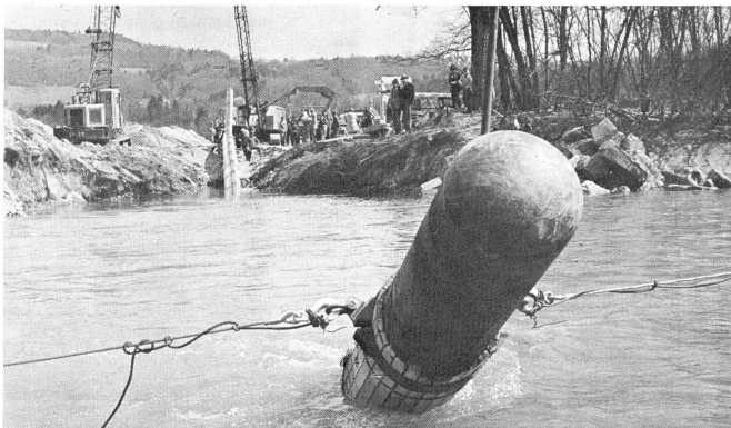
Abb. 1. Verlegearbeiten an der Swissgas-Leitung West bei Dürrenäsch Abb. 2. Verlegung des Reuss-Dükers der Swissgas-Leitung West bei Fischbach-Götsikon
