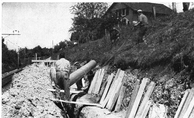
KALIDUR-Kanalisationsrohre, verlegt im Bahneinschnitt
