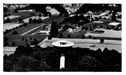
Türme zur Speicherung von Trinkwasser stehen vor allem in topfebenen Ländern. Durch die Speicherung des Wassers in den eleganten Bauwerken ist der nötige Druck im Wasserleitungssystem gewährleistet. Das Bild zeigt den Wasserturm von Allschwil BL. (Flugaufnahme: Comet).
