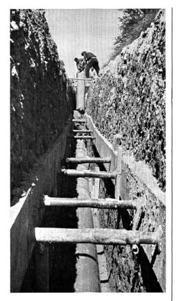
Abb. 4. Kunststoffrohre: Absenken eines 5 m langen Rohres durch zwei Arbeitskräfte
