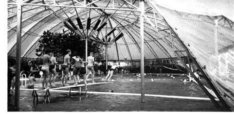
Abb. 1. Aussenansicht des Zelthallenbades Lommerbergen, teilweise geöffnet. Im Hintergrund sind die durchsichtigen Plasticfolien erkennbar, die die Halle nach unten vollständig schliessen. Im Vordergrund eine der Zuluftöffnungen
