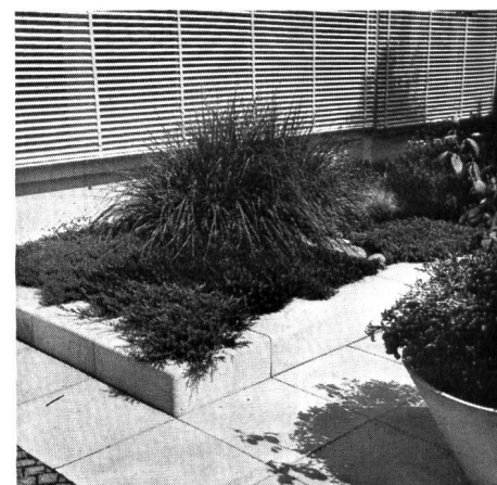
Abb.1. Dachgarten mit 17 cm Schichthöhe. Als Rand dient das niedere optima-Dachgartenelement
