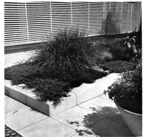
Abb. 1. Dachgarten mit 17 cm Schichthöhe. Als Rand dient das niedere optima-Dachgartenelement
