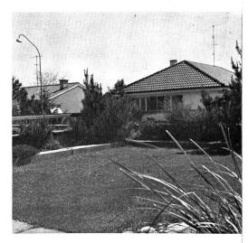
Abb. 2. Dachgarten nach optima-System mit einer 6 cm starken Erdschicht für Rasen und 12 cm für Kleinsträucher
