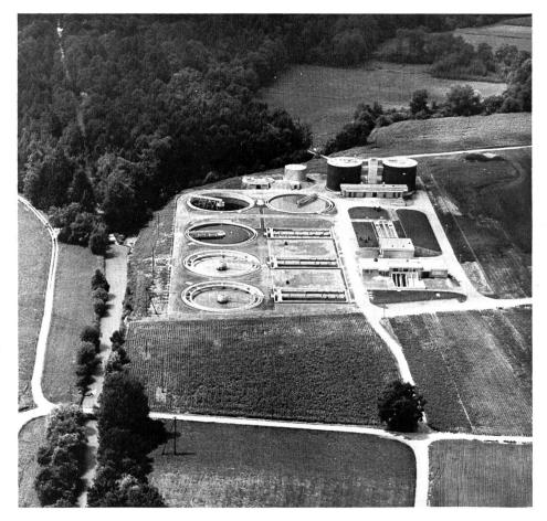
schlammanlage (drei Einheiten zu je 1200 m³) zugeführt. Die Möglichkeit für einen zweistufigen Betrieb ist gegeben. In drei Rundbecken mit je 1700 m³ Inhalt wird die Nachklärung vollzogen, wonach das gereinigte Wasser in den Vorfluter, den Fabrikkanal zur Thur, zurückfliesst.
