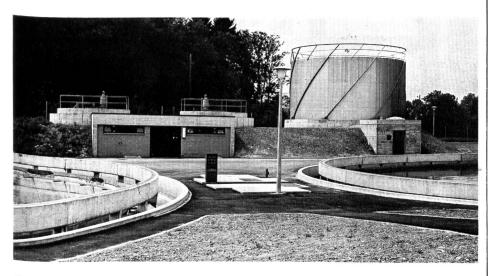
Abb. 2. Die Absetzbecken, im Hintergrund Faultürme und Gasometer mit Maschinenhaus
