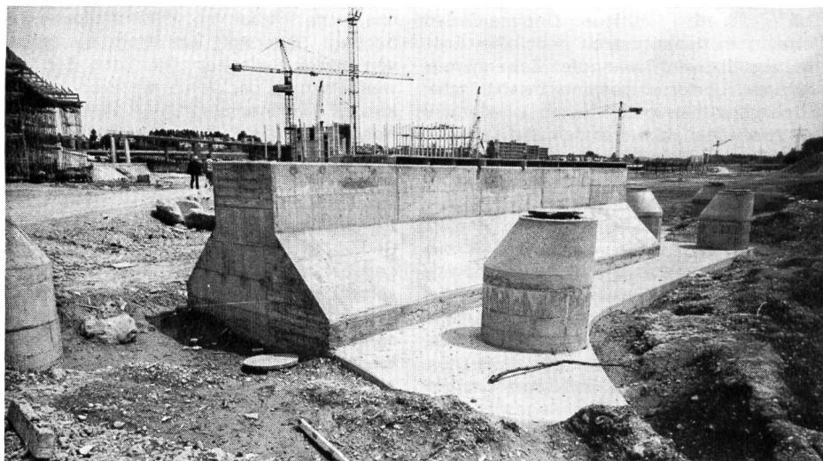
Abb. 3. Vorsorge gegen Oelunfälle auch an Nationalstrassen: Diese Abscheider sind an der N1 bei der Zürcher Stadtgrenze eingebaut worden, um bei allfälligen Tankwagenunfällen die auslaufenden Flüssigkeiten abzuscheiden und so der Grundwasserverschmutzung vorzubeugen (Foto: Comet)
