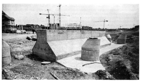
Abb. 3. Vorsorge gegen Oelunfälle auch an Nationalstrassen: Diese Abscheider sind an der N1 bei der Zürcher Stadtgrenze eingebaut worden, um bei allfälligen Tankwagenunfällen die auslaufenden Flüssigkeiten abzuscheiden und so der Grundwasserverschmutzung vorzubeugen (Foto: Comet)
