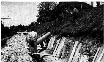
KALIDUR-Kanalisationsrohre, verlegt im Bahneinschnitt
