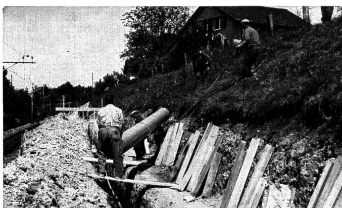
KALIDUR-Kanalisa-tionsrohre, verlegt im Bahneinschnitt
