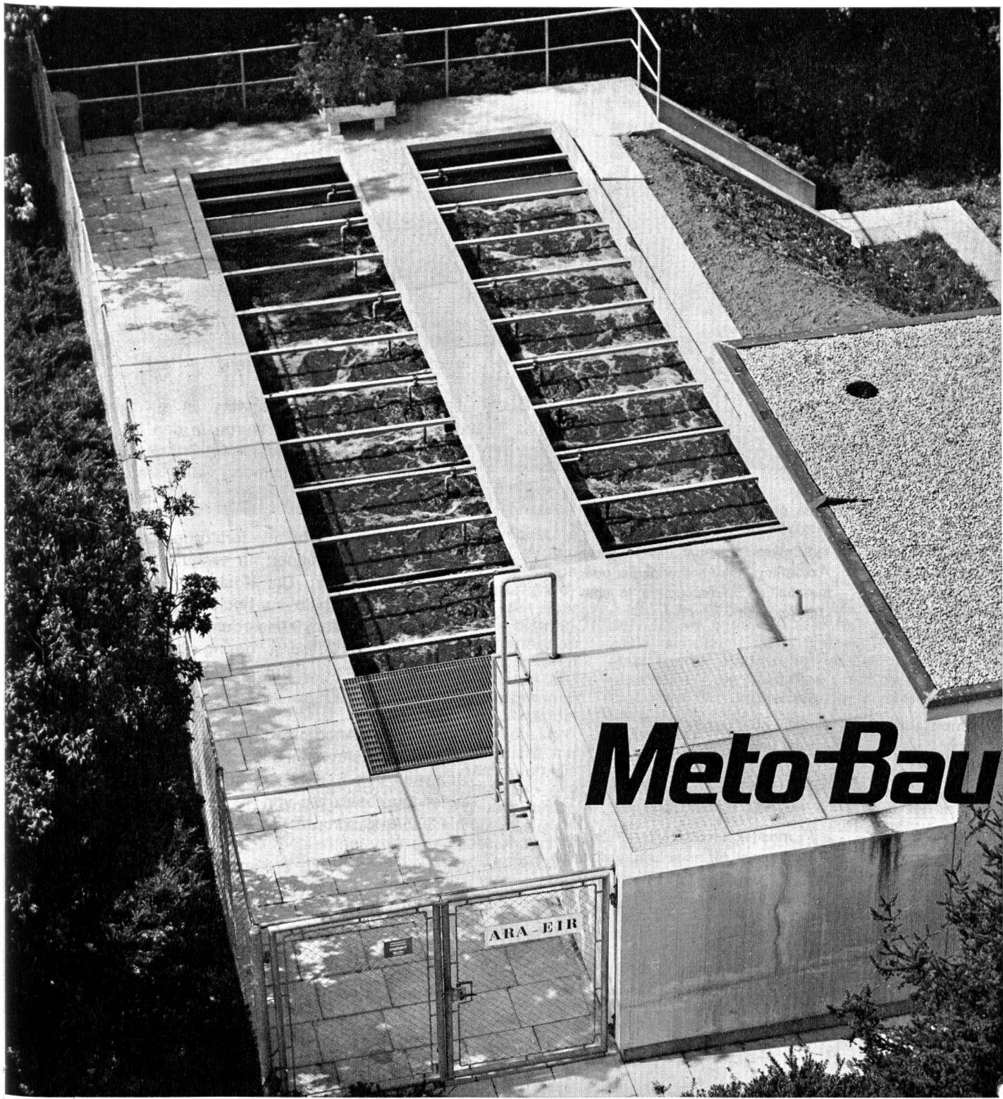
Belüftungsbecken der  $2 \times 60 \text{ m}^3$  Metoxy®-Kläranlagen des EIR in Würenlingen für etwa 700 EGW, geliefert 1969 durch die Meto-Bau AG
