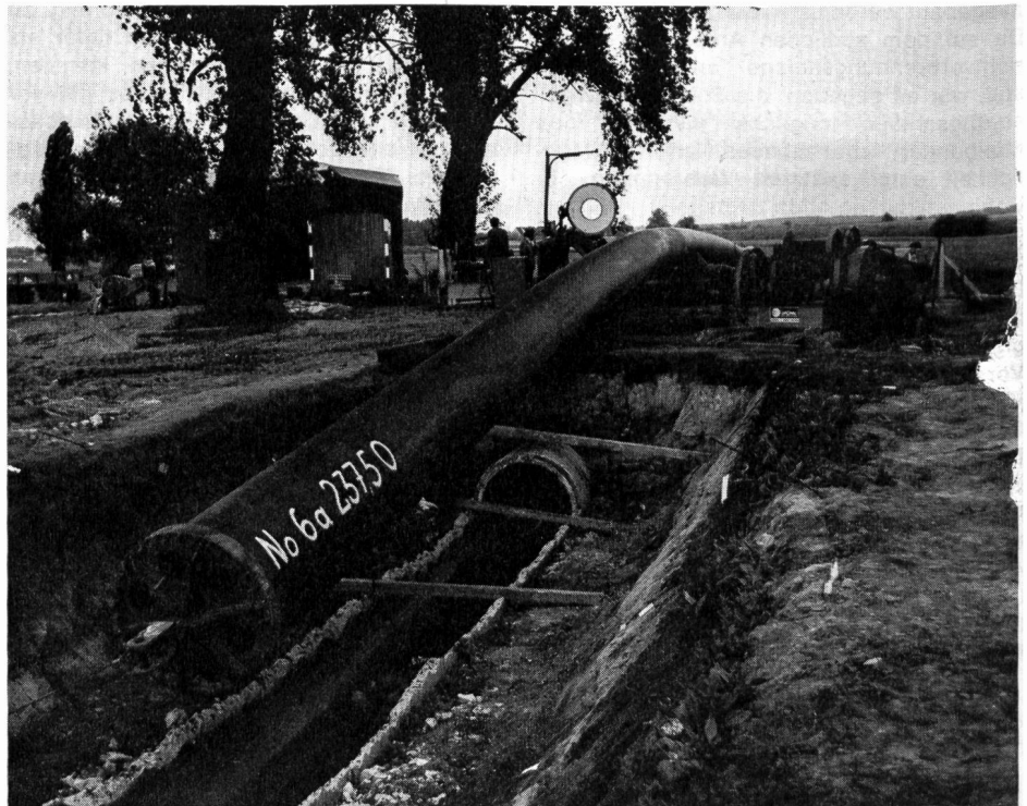
Abb. 1. Ueber ein Rollenlager, das die Reibung herabsetzt, werden die Rohre in den auf einer Strecke von 50 m aufgebrochenen alten Kanal (Mitte unten) eingezogen. Eine Grosswinde am Altrhein, wo der Kanal mündet, zieht die Rohre mittels eines Drahtseils (links unten) durch. Links zwischen den Bäumen ist das Zelt, das für das Schweissen nötig war, zu erkennen. Nur für Demonstrationszwecke hat man die Schweissanlage ins Freie gebracht und links neben dem Rohr aufgebaut
