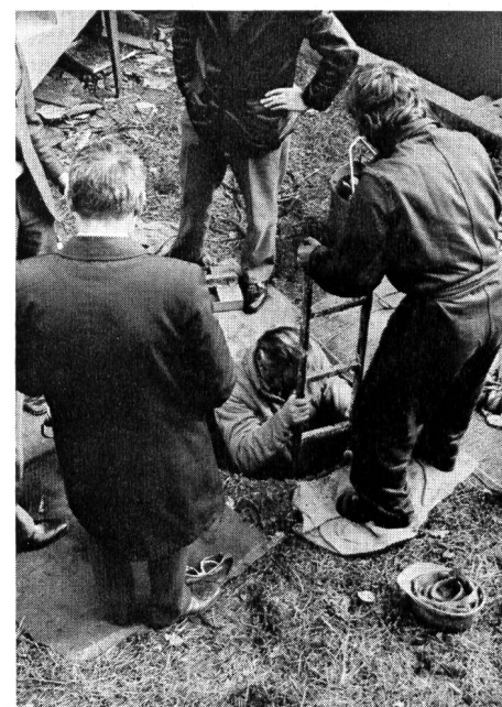
Abb. 7. Nach beendigter Arbeit klettert der Experte selber in den Tank, um durch Augenschein die Bewertung festlegen zu können
