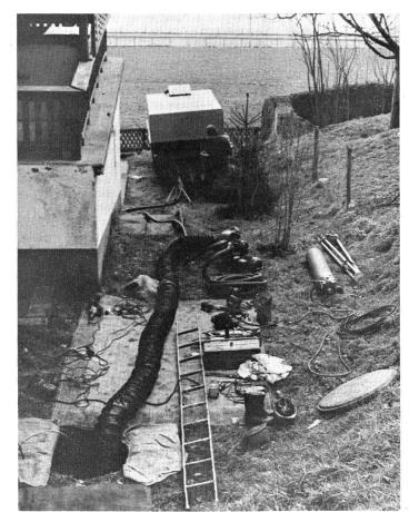
Abb. 5. Dieses Werkzeugarsenal muss nach beendigter Arbeit wieder im Revisionsfahrzeug Platz finden. Der in der Mitte erkennbare Schlauch sorgt für die einwandfreie Belüftung des Tanks
