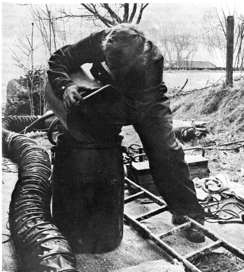
Abb. 7. Nach beendigter Arbeit klettert der Experte selber in den Tank, um durch Augenschein die Bewertung festlegen zu können
