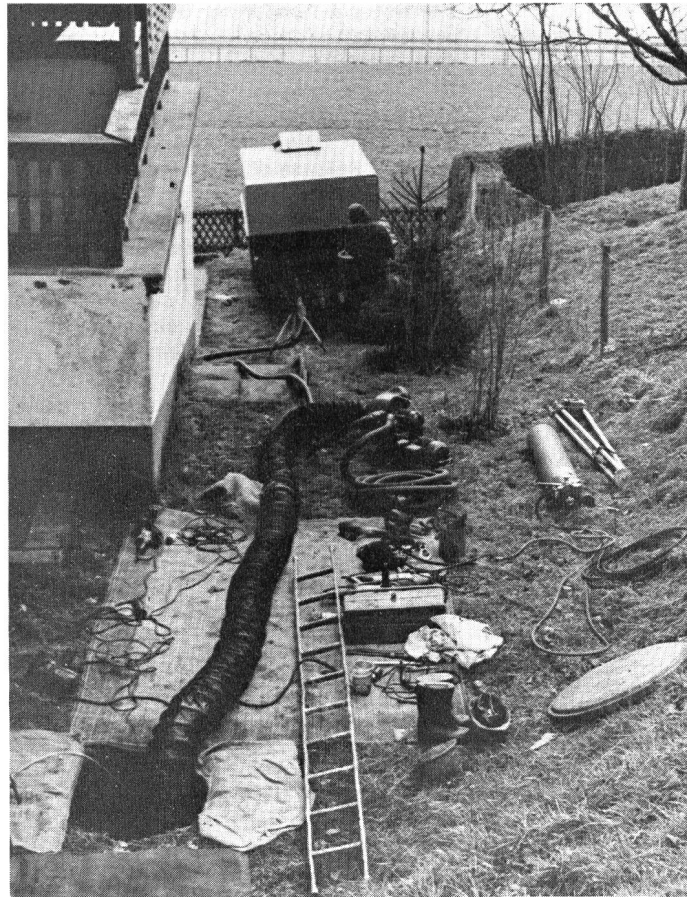
Abb. 5. Dieses Werkzeugarsenal muss nach beendiger Arbeit wieder im Revisionsfahrzeug Platz finden. Der in der Mitte erkennbare Schlauch sorgt für die einwandfreie Belüftung des Tanks
