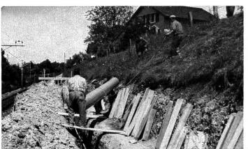
KALIDUR-Kanalisationsrohre, verlegt im Bahneinschnitt
