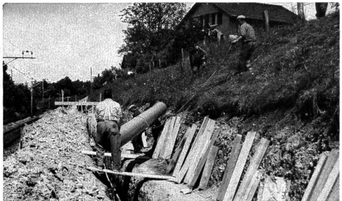
KALIDUR-Kanalisationsrohre, verlegt im Bahneinschnitt
