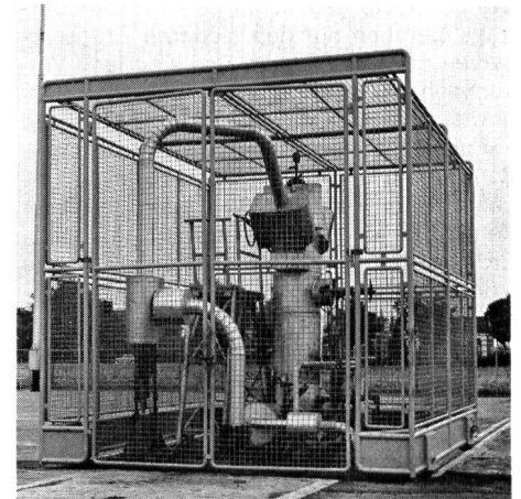
Abb. 4. Erdgasschieber in Groningen
