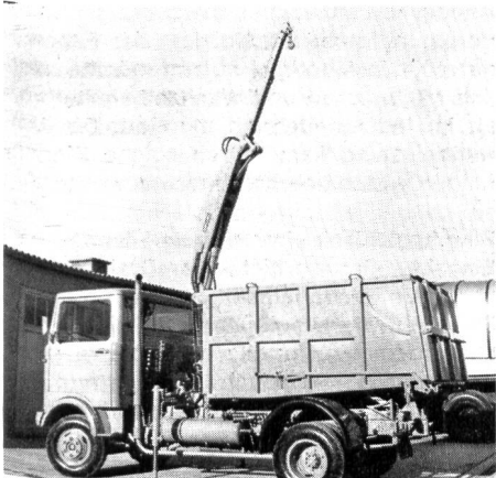
Abb. 3. Das Kuka-Kontifakat-Fahrzeug, ausgerüstet für eine Beladung mittels Kran
