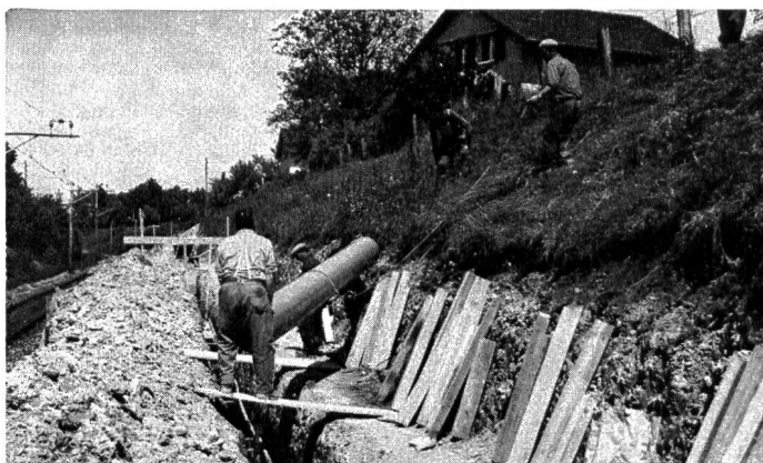
KALIDUR-Kanalisationsrohre, verlegt im Bahneinschnitt
