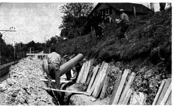
KALIDUR-Kanalisationsrohre, verlegt im Bahneinschnitt
