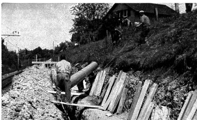
KALIDUR-Kanalisationsrohre, verlegt im Bahneinschnitt
