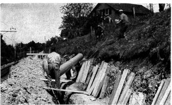
KALIDUR-Kanalisationsrohre, verlegt im Bahneinschnitt
