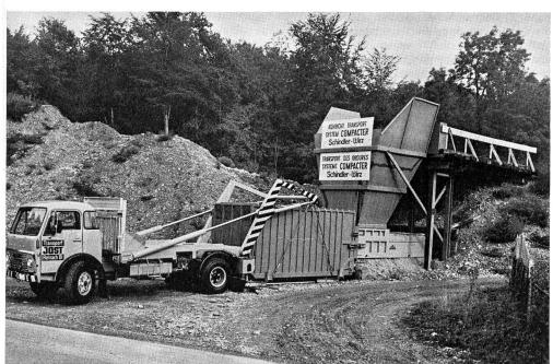
Abb. 1. Kehrichtverladestation System Compacter-Schindler-Wirz mit 20-m³-Container, Stopfpressanlage und Schwenklader. Fassungsvermögen des Einfülltrichters 25 bis 35 m³
