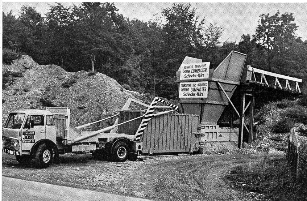
Abb. 1. Kehrriechverladestation System Compacter-Schindler-Wirz mit 20-m 3 -Container, Stopfpressanlage und Schwenklader. Fassungsvermögen des Einfülltrichters 25 bis 35 m 3
