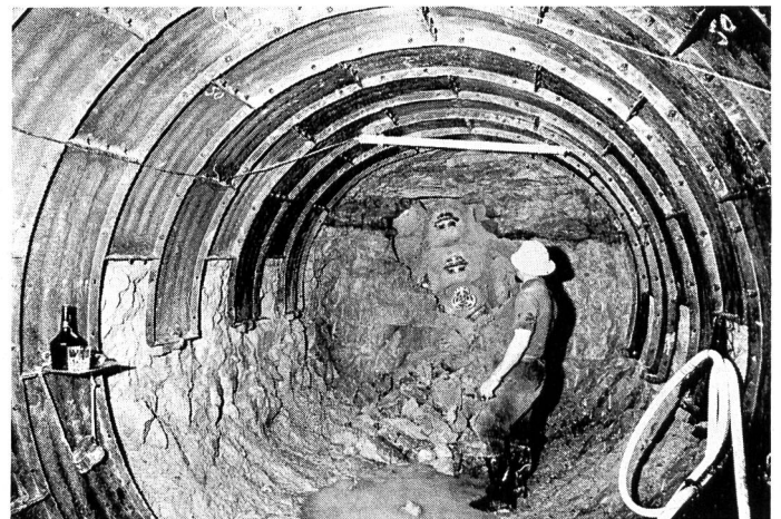
Abb. 2. Stollendurchbruch mit Robbins-Fräse am 28. Mai 1968
