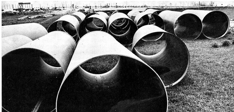
u. sch. Im Rahmen des Nationalstrassenbaus im Raum Genf und der Sanierung eines Teils des Beckens, das sich in den Vengeron ergießt, verlegte ein Unternehmerkonsortium zum erstenmal in der Schweiz glasfaserverstärkte Polyesterrohre Armaveron mit dem Durchmesser von 150 cm. Lieferant dieser Rohre ist die Armaveron, die Kunststoffabteilung der Basler Stückfärberei AG.
