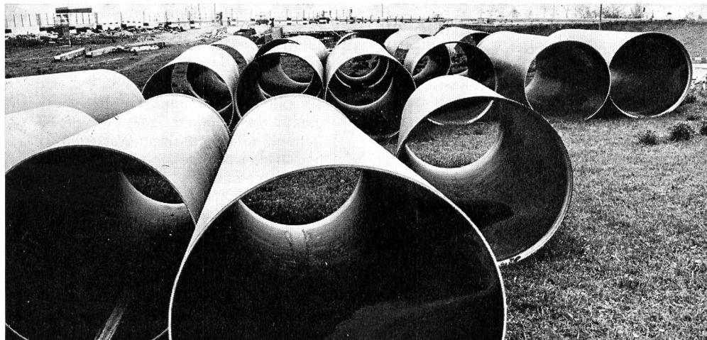
u.sch. Im Rahmen des Nationalstrassenbaus im Raum Genf und der Sanierung eines Teils des Beckens, das sich in den Vengeron ergießt, verlegte ein Unternehmerkonsortium zum erstenmal in der Schweiz glasfaserverstärkte Polyesterrohre Armaveron mit dem Durchmesser von 150 cm. Lieferant dieser Rohre ist die Armaver, die Kunststoffabteilung der Basler Stückfärberei AG.
