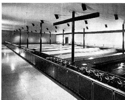
In Muttenz filtrieren Häny-Quarzsandfilter täglich rund 200000 m<sup>3</sup> Wasser (Versorgungsgrundlage der Region Basel). Das Rohwasser wird dem Rhein entnommen, über offene Filter geleitet und zur Anreicherung des Grundwasserstromes im Hardwald zur Versickerung gebracht.
