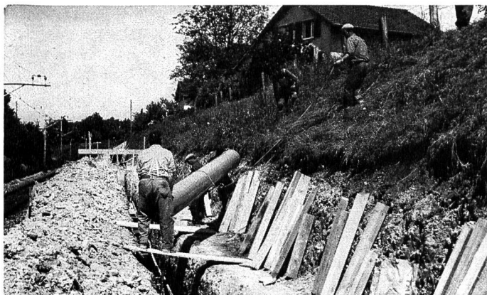
KALIDUR-Kanalisa-tionsrohre, verlegt im Bahneinschnitt
