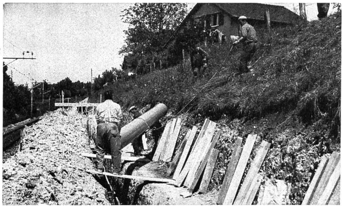
KALIDUR-Kanalisationsrohre, verlegt im Bahneinschnitt
