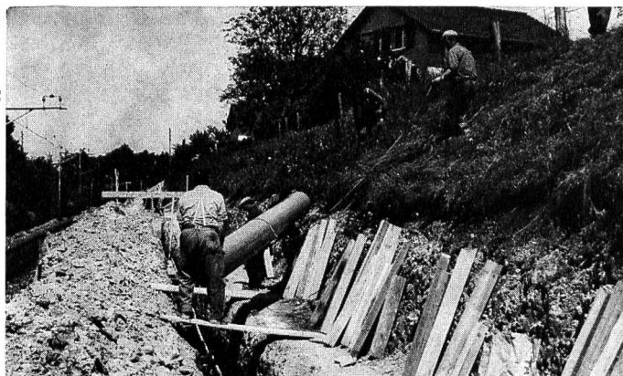
KALIDUR-Kanalisationsrohre, verlegt im Bahneinschnitt
