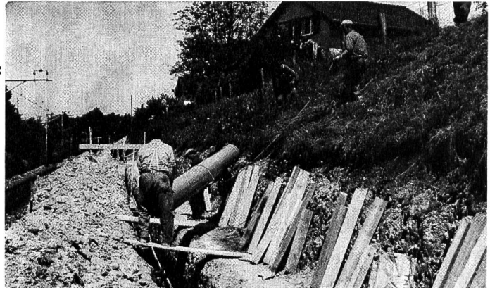
KALIDUR-Kanalisationsrohre, verlegt im Bahneinschnitt
